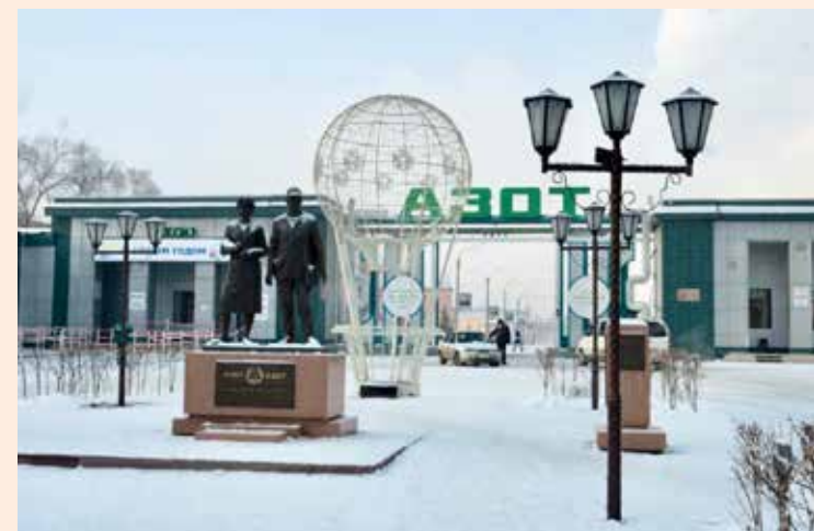
▲ Работы по реконструкции газопровода будут завершены в 2021 году
