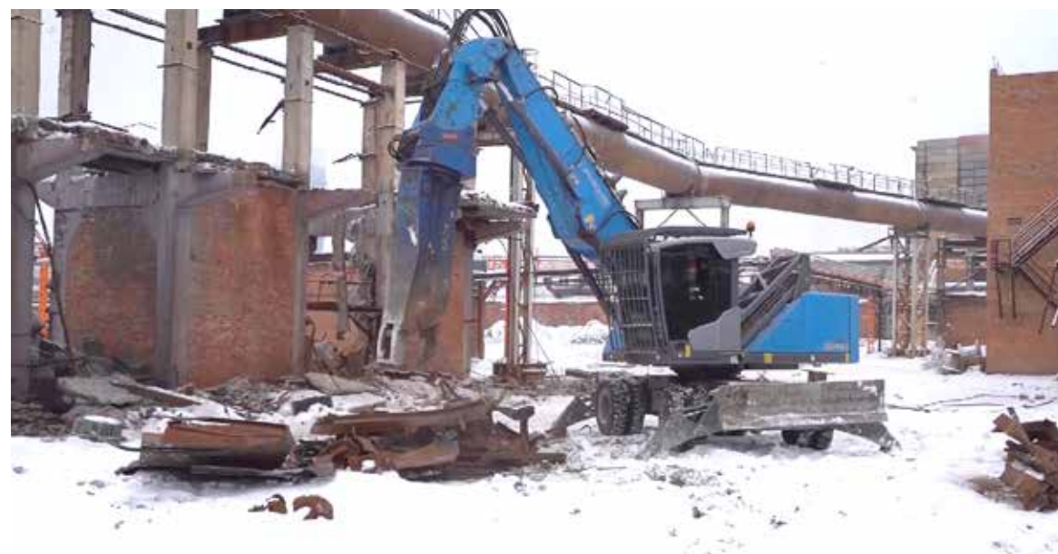
▲ Перегружатель Terex Fuchs оснащён тремя рабочими органами: грейферной установкой, гидравлическими ножницами и электромагнитом
