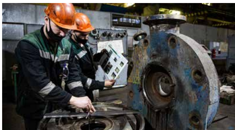
▲ Механики цеха УГМ № 3 ремонтируют оборудование, опираясь на СОП
