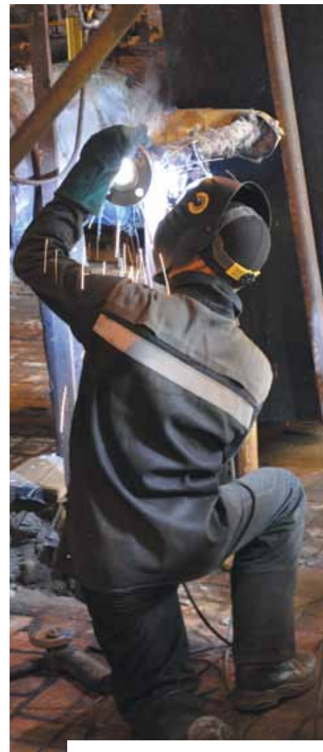
Замена клапанов на линии газообразного аммиака в цехе № 13
