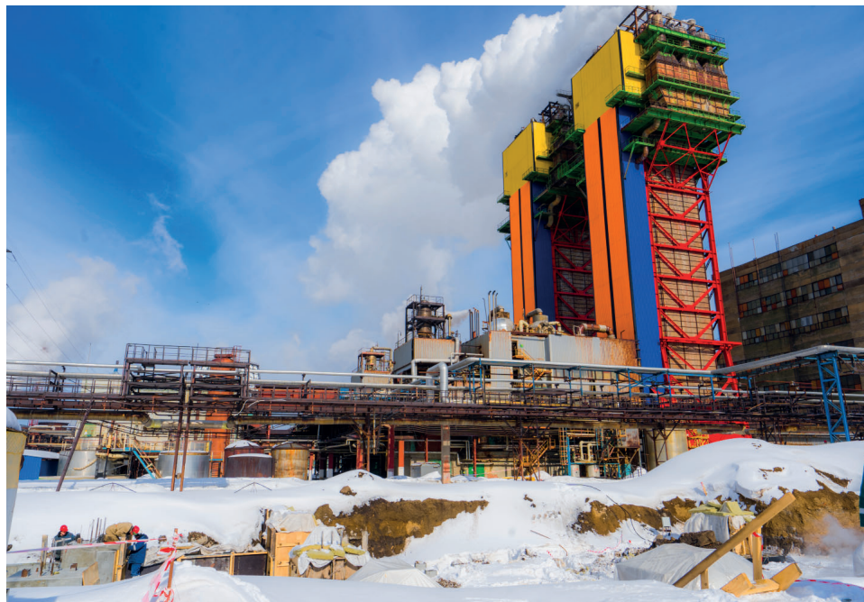
▲ Строительно-монтажные работы нулевого цикла завершены на 70%
