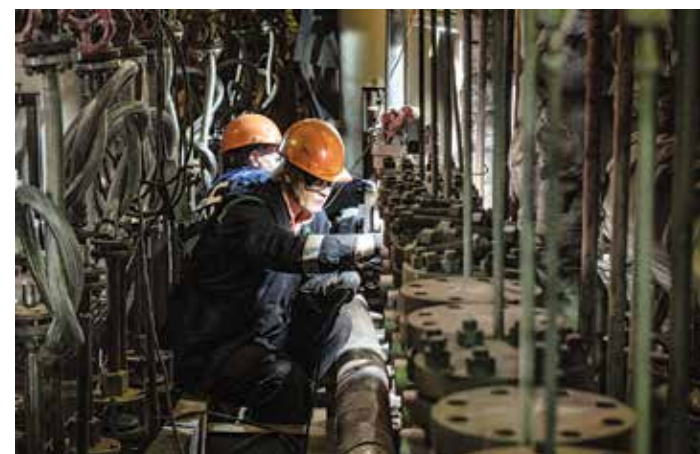
▲ Печь риформинга поз. 107 — одна из лимитирующих позиций капитального ремонта на первом агрегате аммиака
