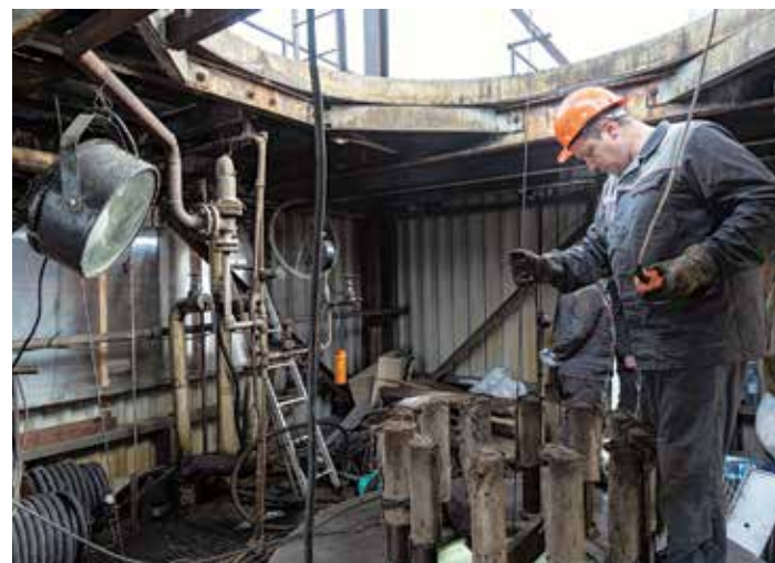
▲ Ремонт реактора синтеза цеха Карбамид проведен силами ОАО «НИИК»
