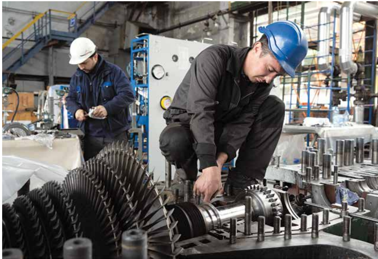
▲ Диагностика и ремонт динамического оборудования — важная часть капитального ремонта в цехе Аммиак-1
