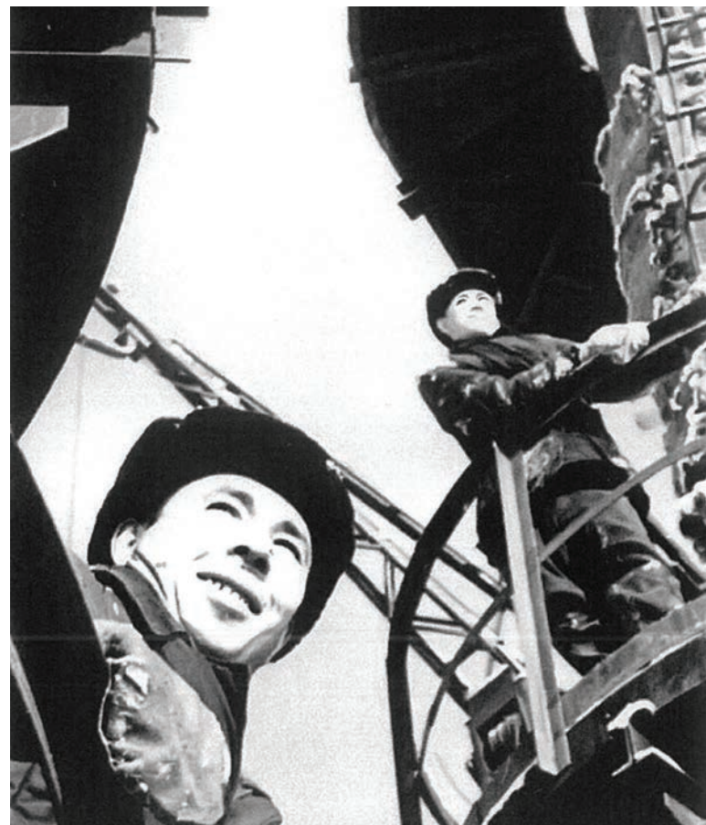
▲ Монтаж ректификационной колонны на производстве капролактама
