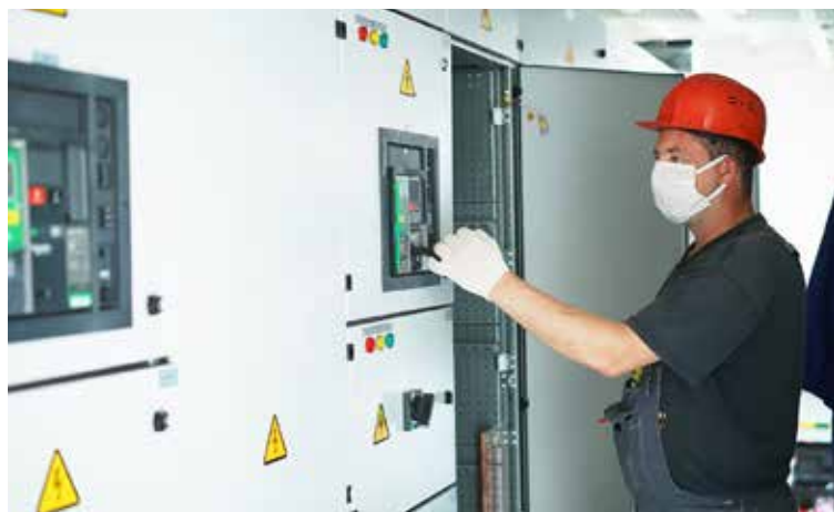
▲ Подстанция снабдит электроэнергией новое оборудование цеха сульфата аммония
