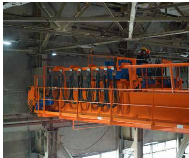
▲ Новый мостовой кран смонтирован на отметке 16,3 метра
