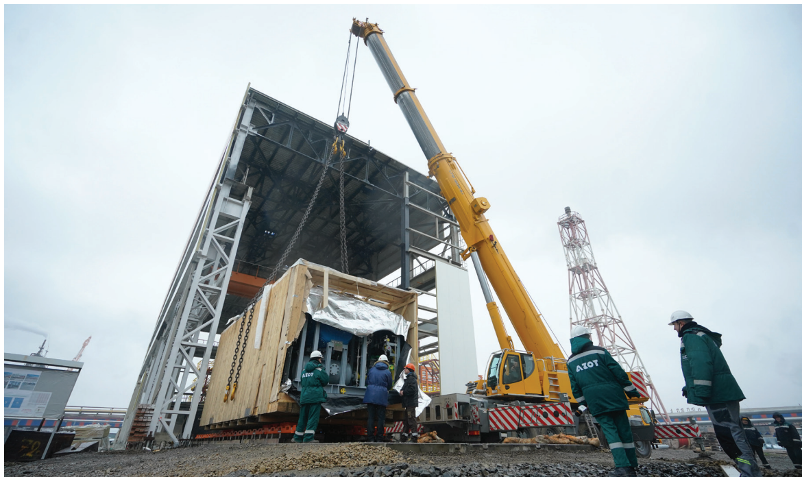
▲ Вес поршневого газового компрессора — 67 тонн
