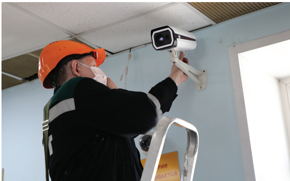
▲ Тепловизионный комплекс может определить температуру у 30 человек одновременно
