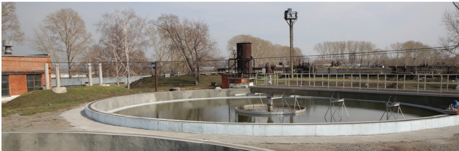
▲ Вторичные радиальные отстойники поз. 1, 2. Служат для разделения активного биологического ила и очищенного стока
