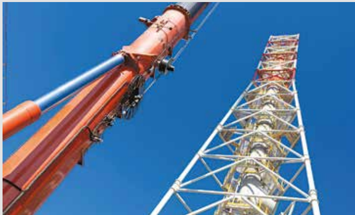
Завершается монтаж 90-метровой трубы для сброса отработанных газов
