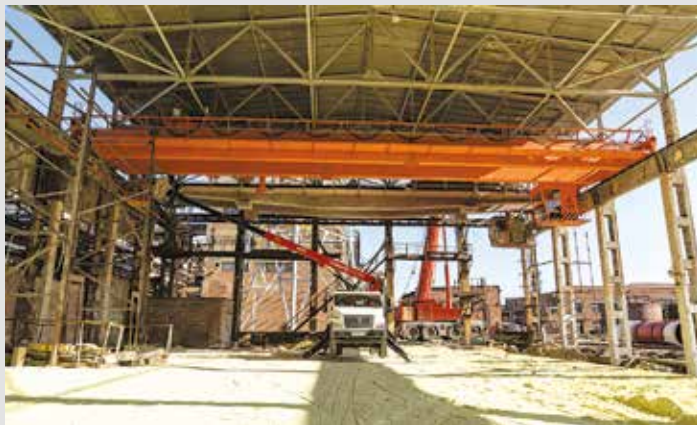
Замена грейдерного крана на складе серы
