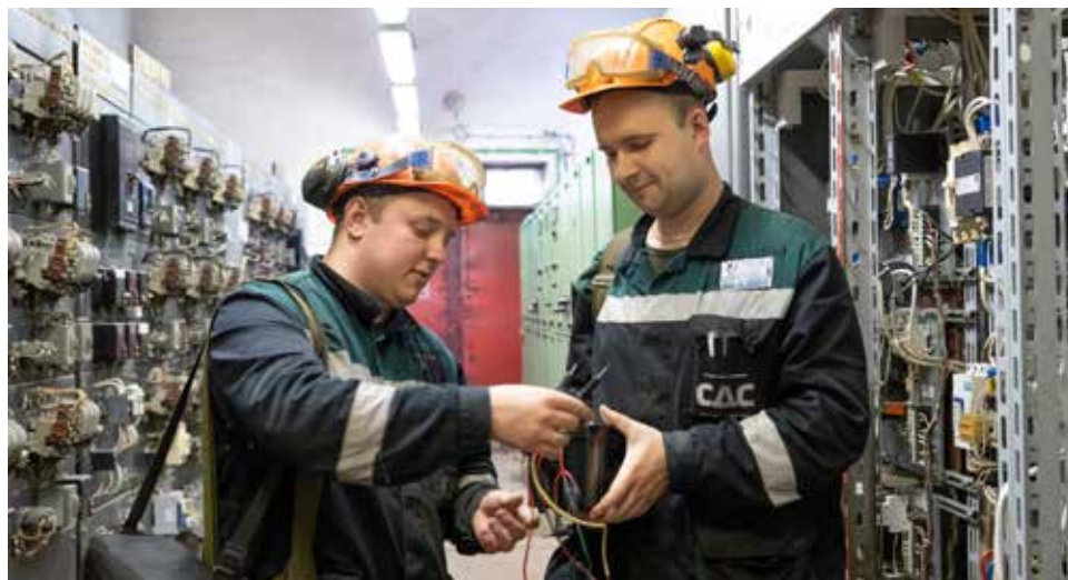
▲ Электромонтеры ЦСОЭ Евгений Венков и Игорь Очнев
