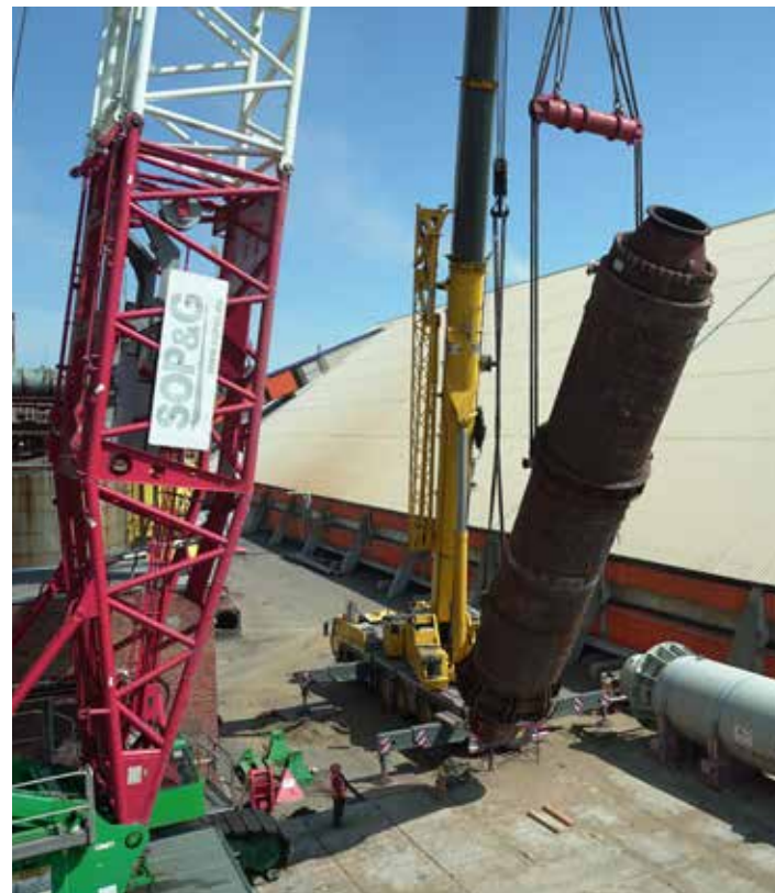
▲ Конденсатор 1-й ступени дистилляции для цеха карбамида изготовлен во Франции
