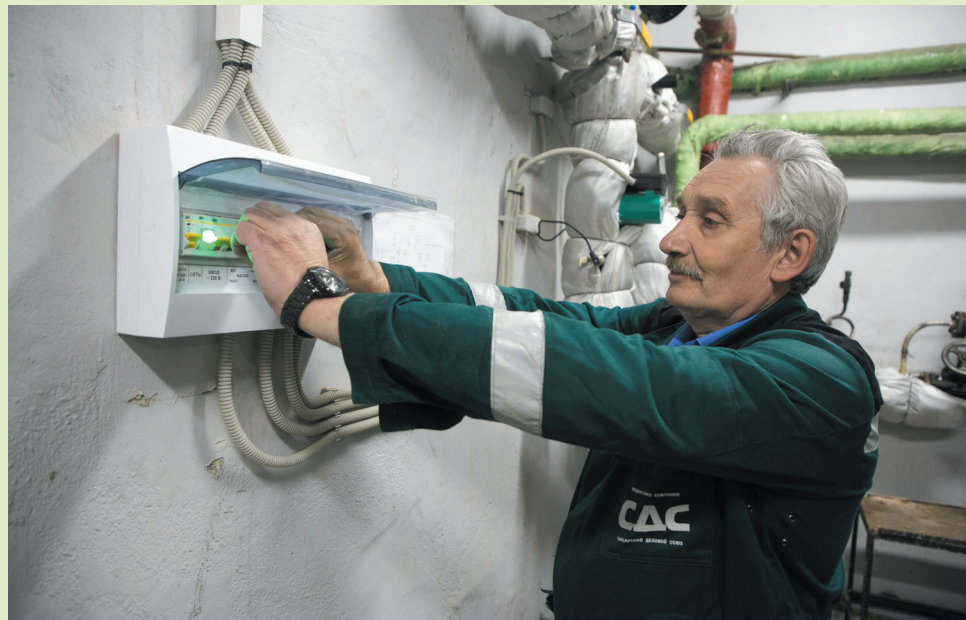
Автоматизированная система управления теплоснабжением уже работает в корпусе Центральной лаборатории
