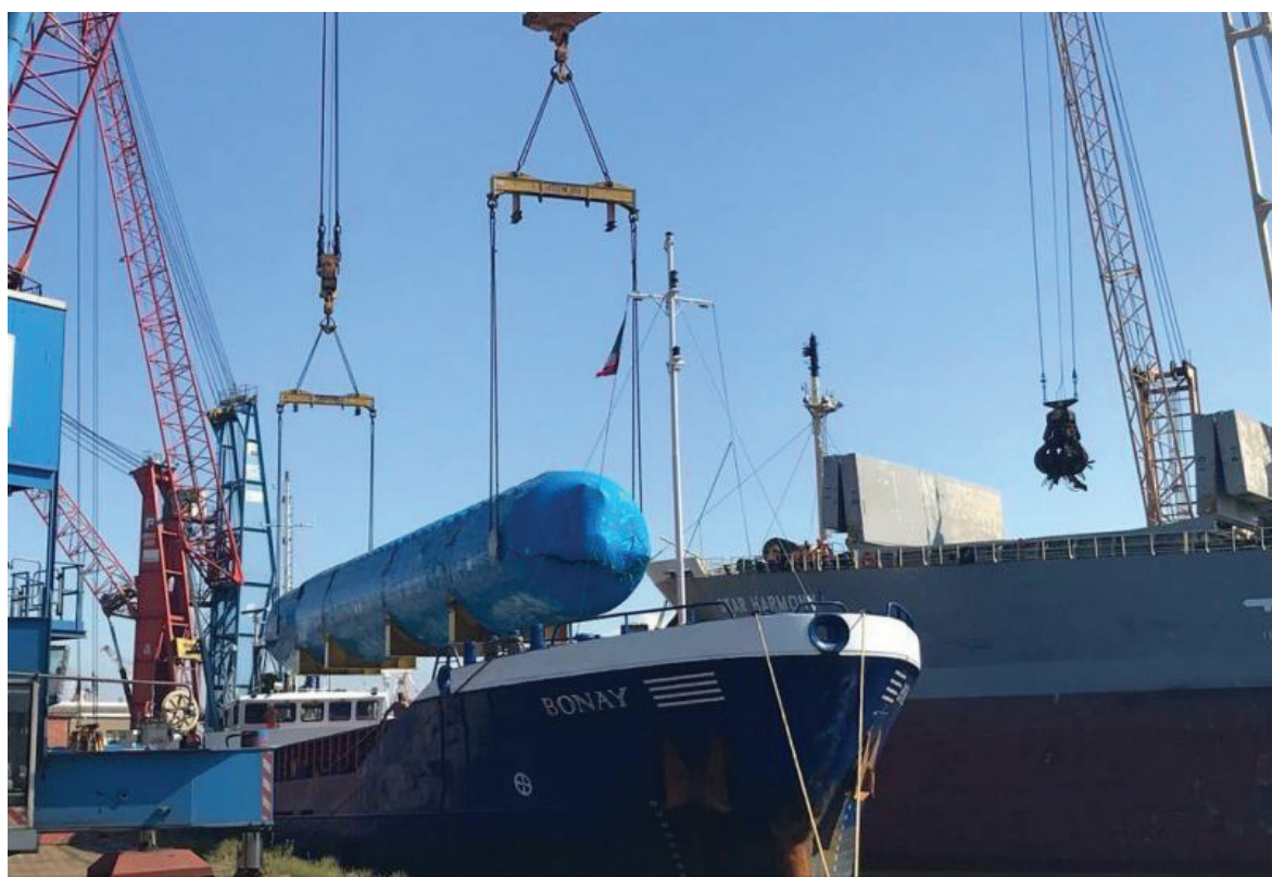
Сложность транспортировки абсорбционной колонны в её габаритах — высота составляет почти 40 метров, диаметр — 4,2 метра
