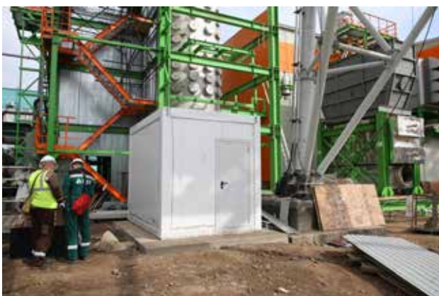
▲ Поставку оборудования и строительство установки выполняет компания ООО «СТЭП».
