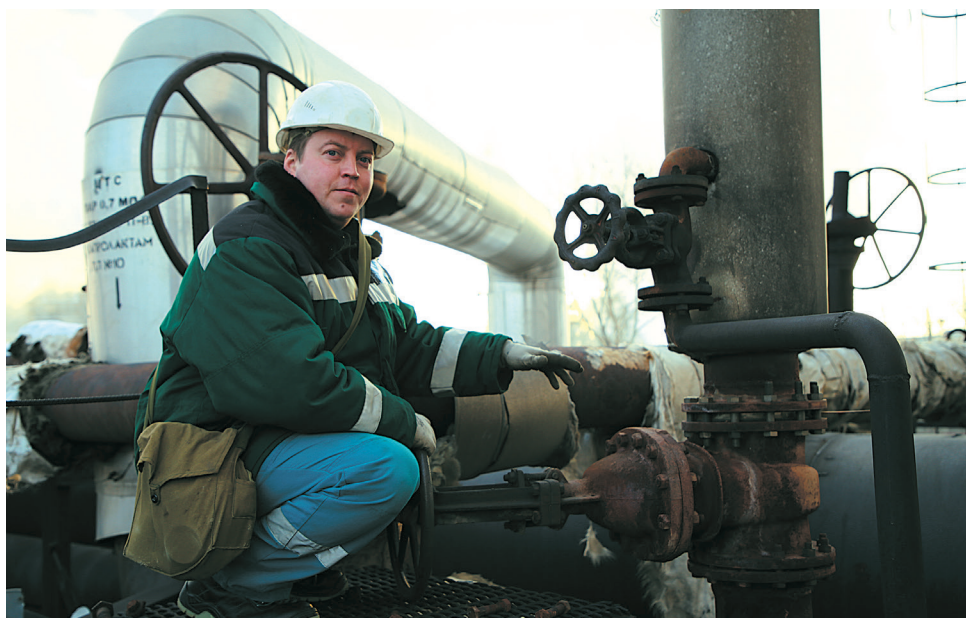
Александр Сбитнев рядом с «отглушенным» трубопроводом.
